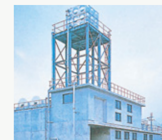
瀬戸内海環境基準をクリアする排水処理設備の染色工場
